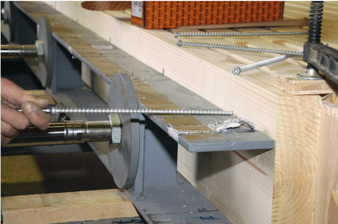
Die einzelnen Hölzer werden nicht wie üblich miteinander vernagelt, sondern mittels Doppelgewindeschrauben kraftschlüssig verschraubt.
